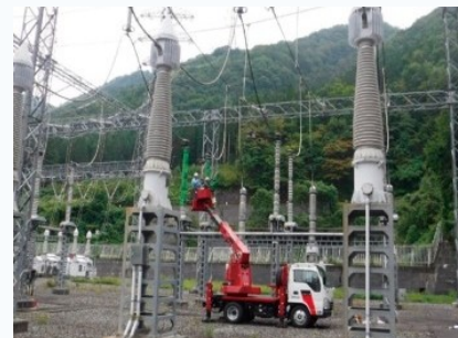
変電設備工事
