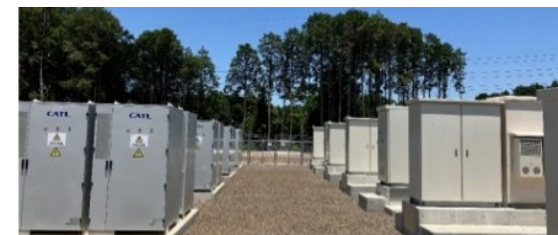
佐賀県 武雄蓄電所建設工事 定格出力2MW、定格容量8MWh
