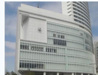
商業施設内電気設備工事
