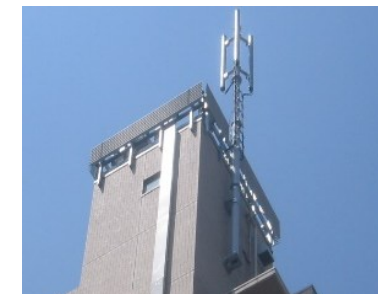
▲移動体通信工事
