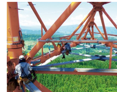
▲架空送電線設備保守業務委託工事
