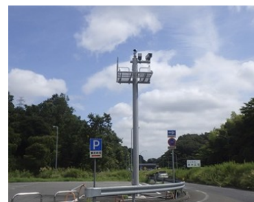
▲監視カメラ設備工事
