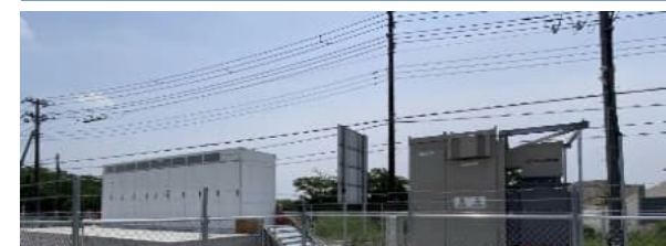
茨城県 蓄電所建設工事 定格出力2MW、定格容量4MWh
