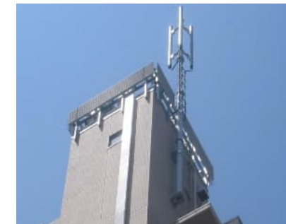
▲移動体通信工事
