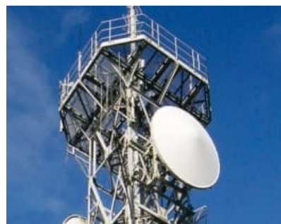
▲防災行政無線工事
