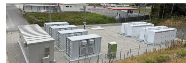
福岡県 蓄電所建設工事 定格出力8MW、定格容量16MWh
