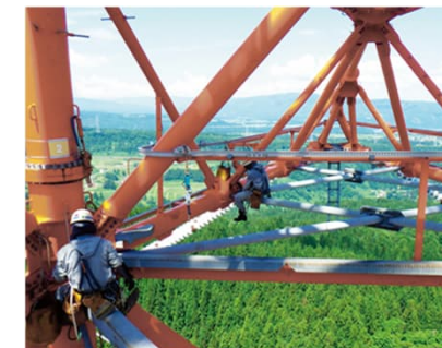
▲架空送電線設備保守業務委託工事
