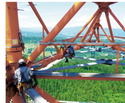
▲架空送電線設備保守業務委託工事
