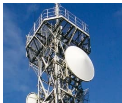
▲防災行政無線工事
