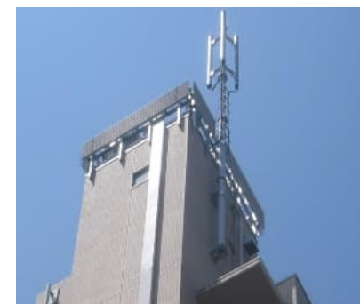
▲移動体通信工事
