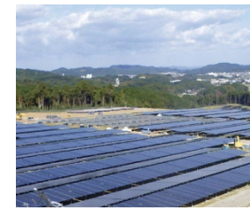
▲太陽光発電設備工事
