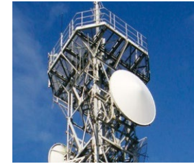
▲防災行政無線工事
