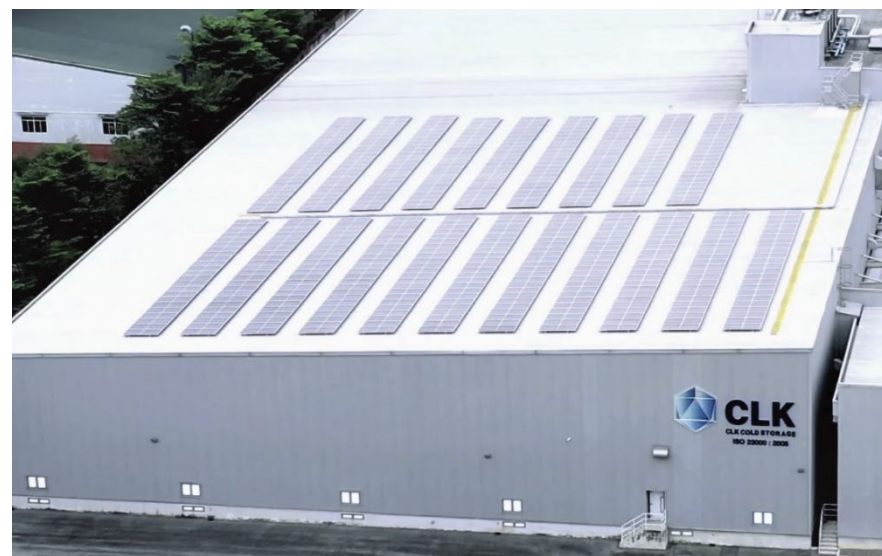
CLK COLD STORAGE ベトナム工場
