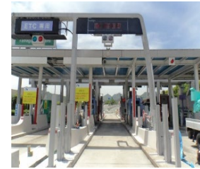
▲高速自動車道ETC設備工事
