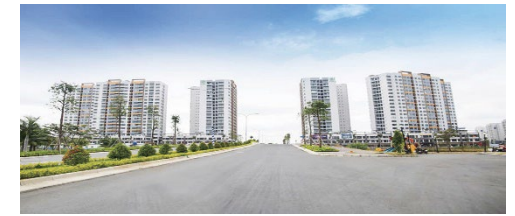
▲ホーチミン フローラミズキプロジェクト (電気設備、空調、給排水、防火設備)
