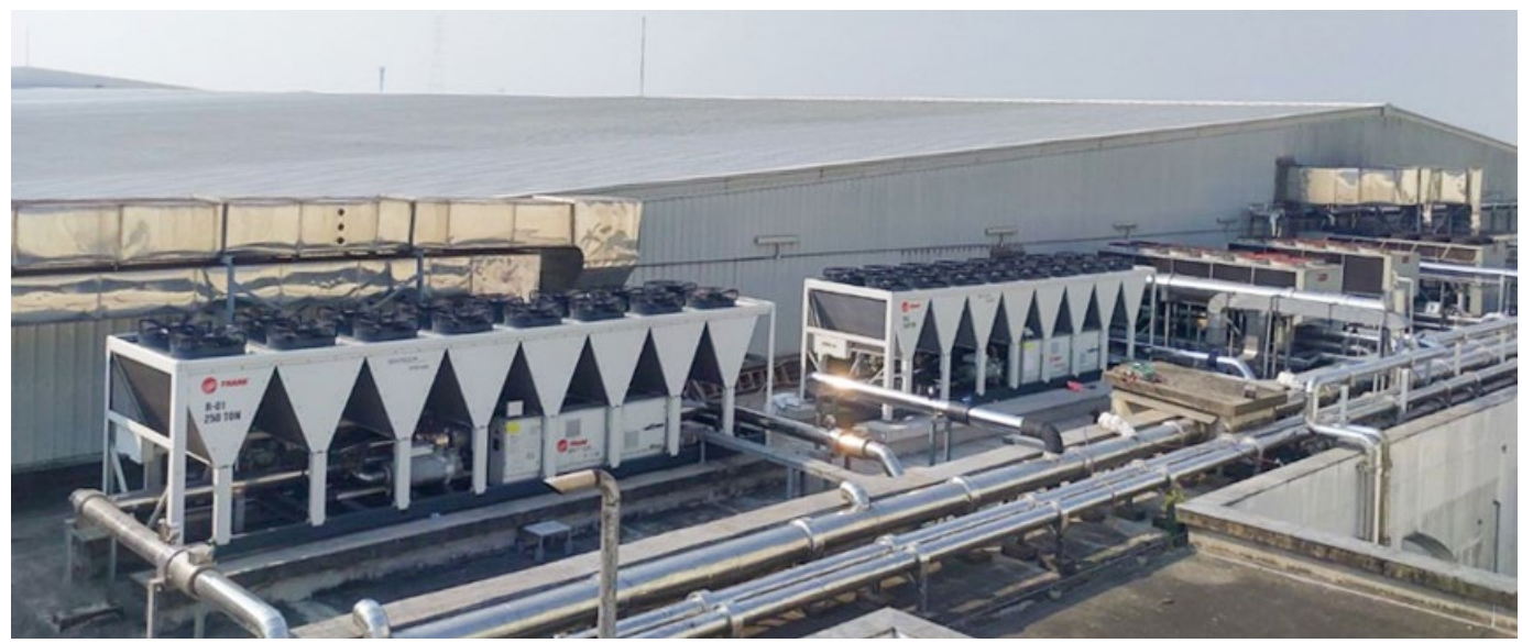
日系企業チラー(冷却水循環装置)設備設置工事
