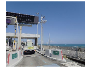
▲高速道路CCTV設備工事
