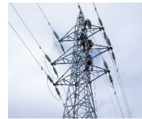
▲架空送電線関連工事
