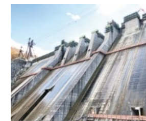
▲八ッ場ダム 電気設備・通信設備工事
