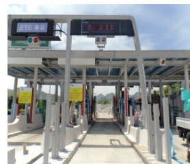
▲高速自動車道ETC設備工事
