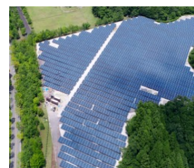
▲太陽光発電設備工事
