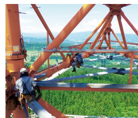
▲架空送電線設備保守業務委託工事
