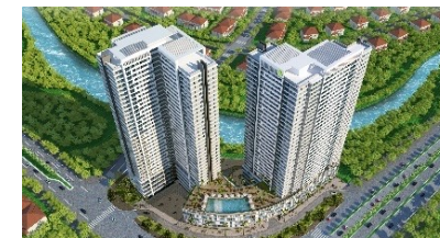
▲サンライズシティビュー (電気・空調衛生設備工事)
