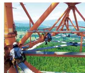
▲架空送電線設備保守業務委託工事
