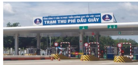
▲ベトナム 南北高速道路 ホーチミン～ソーザイ間 高速道路 (ITS工事)
