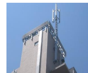
▲移動体通信工事
