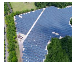
▲太陽光発電設備工事
