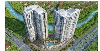
▲サンライズシティービュウ (電気・空調衛生設備工事)
