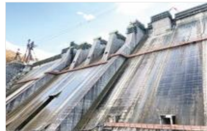
群馬県ハツ場ダム
