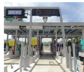
▲高速自動車道ETC設備工事
