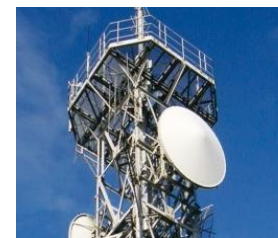
▲防災行政無線工事
