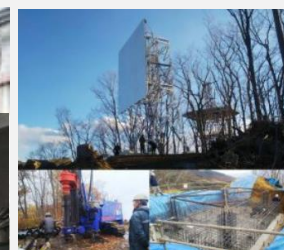
ハツ場ダム 通信設備工事
