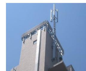
▲移動体通信工事
