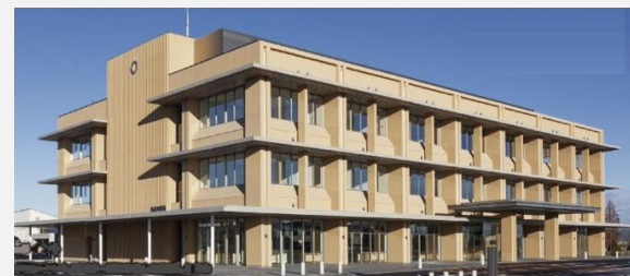
板倉町役場（電気設備工事）
