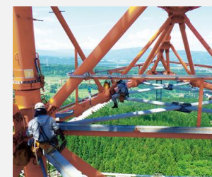
架空送電線設備 保守業務委託工事
