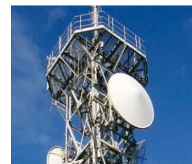
▲防災行政無線工事
