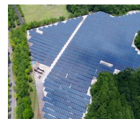
▲太陽光発電設備工事
