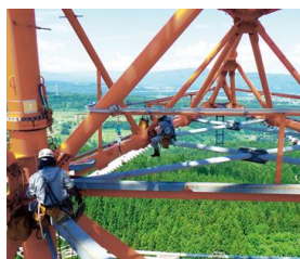
▲架空送電線設備保守業務委託工事
