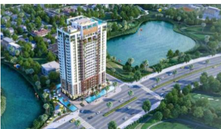
▲アセント・レイクサイド・タワープロジェクト ホアビン建設 受注額2.6億円
