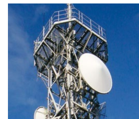
▲防災行政無線工事
