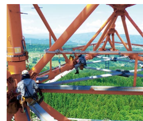
▲架空送電線設備保守業務委託工事
