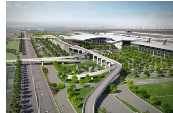
ノイバイ国際空港 ターミナル2：電気設備
