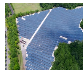
▲太陽光発電設備工事
