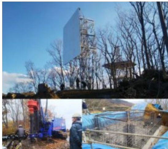
ハツ場ダム 通信設備工事
