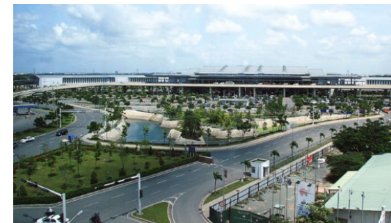
タンソニャット国際空港：電気設備施工監理
