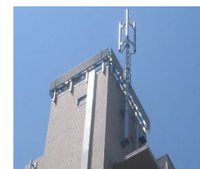
▲移動体通信工事
