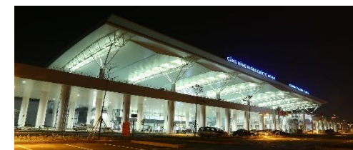
▲ノイバイ国際空港第2ターミナルビル (電気設計・施工管理・電気設備工事)
