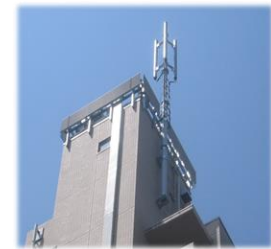
▲移動体通信工事
