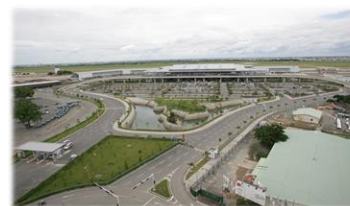
▲カツンキャット国際空港 (電気設備工事の施工管理)
