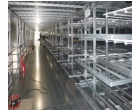
▲植物工場電気設備工事
