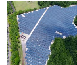
▲太陽光発電設備工事
