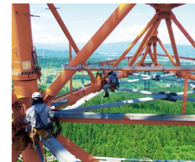
▲架空送電線設備保守業務委託工事
