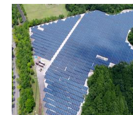
▲太陽光発電設備工事
