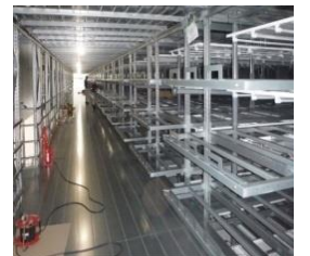
▲植物工場電気設備工事
