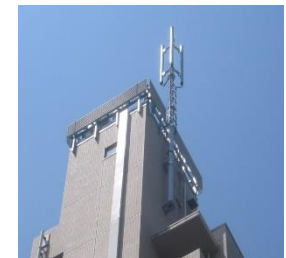
▲移動体通信工事
