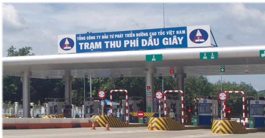
▲ベトナム 南北高速道路 ホーチミン～ゾウザイ間高速道路（ITS工事）
