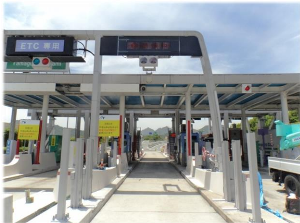
▲高速自動車道ETC設備工事
