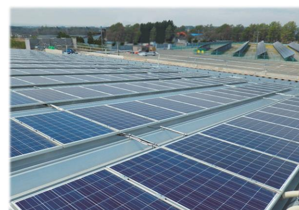
▲太陽光発電設備工事
