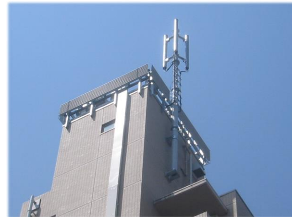
▲移動体通信工事
