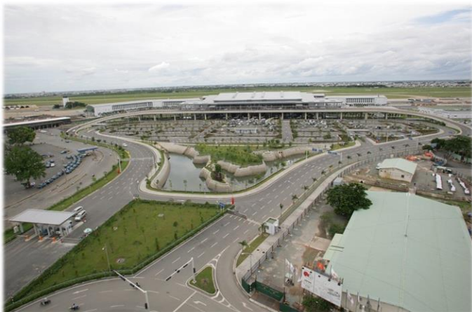
▲タンソンニャット国際空港（電気設備工事の施工監理）
