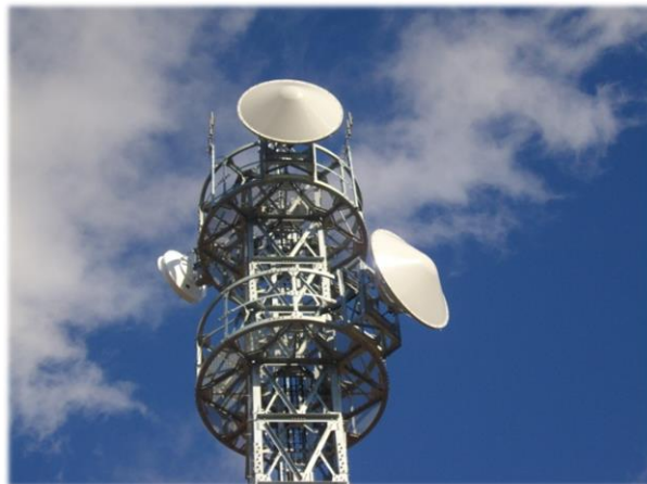
▲防災行政無線工事
