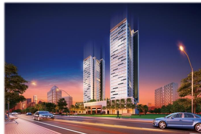
▲アセントコンドミニアムプロジェクト（給排水・電気設備工事）
