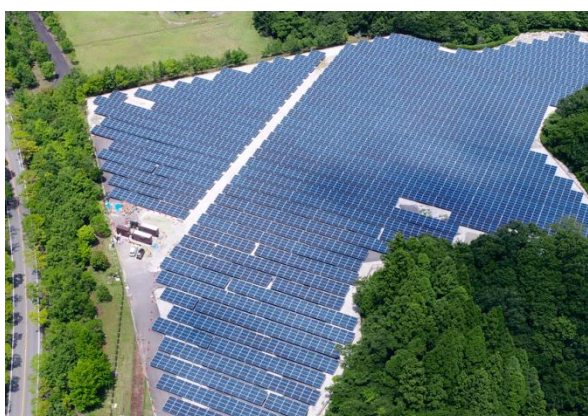
▲ 太陽光発電設備工事
