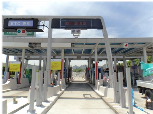
▲ 高速自動車道ETC設備工事
