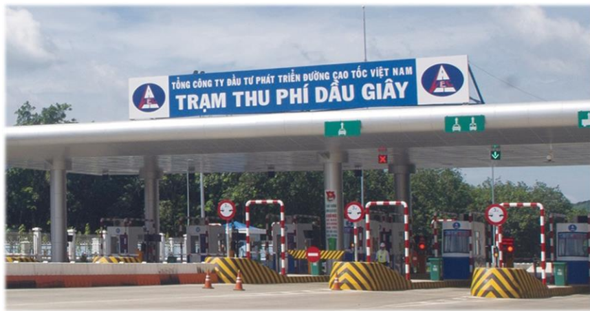
▲ベトナム 南北高速道路 ホーチミン～ゾーザイ間高速道路（ITS工事）
