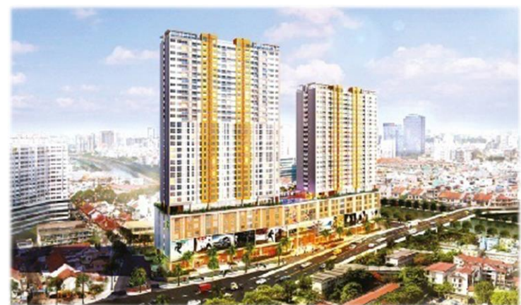
▲リバーゲートレジデンス（電気・空調衛生設備工事）
