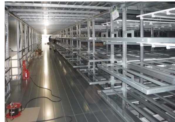
▲ 植物工場電気設備工事
