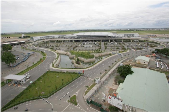
▲タンソンニャット国際空港（電気設備工事の施工管理）
