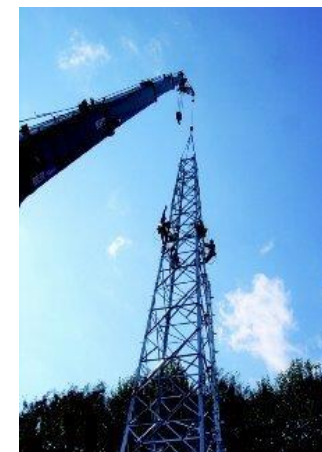
▲鉄塔組立作業
