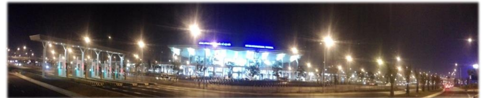
▲ノイバイ国際空港第2ターミナルビル（電気設計・施工管理・電気設備工事）
