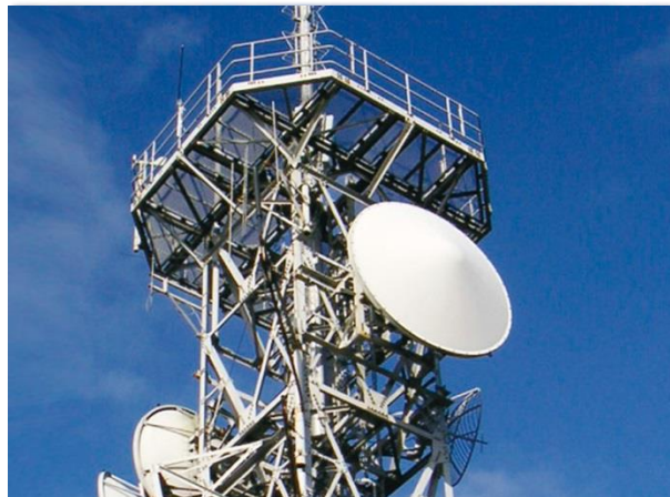
▲ 防災行政無線工事
