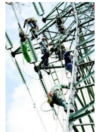
▲送電線架線作業
