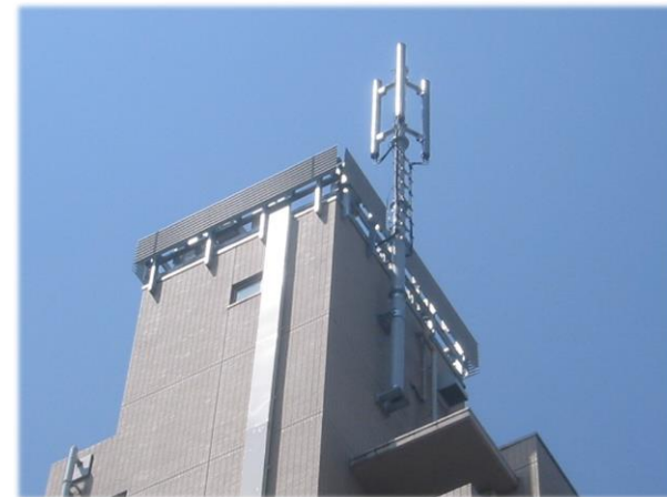
▲ 移動体通信工事
