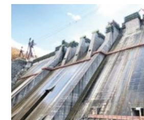
▲ハツ場ダム 電気設備・通信設備工事
