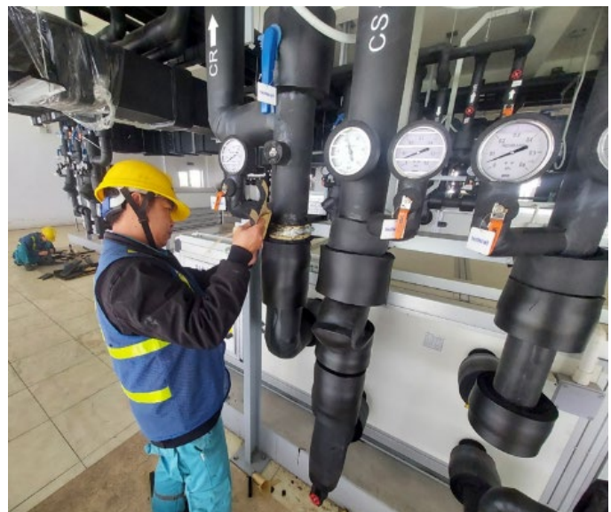
日系企業チラー (冷却水循環装置) 配管工事、機械電気工事
