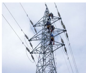
▲架空送電線関連工事
