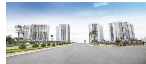
▲ホーチミン フローラミズキプロジェクト (電気設備、空調、給排水、防火設備)
