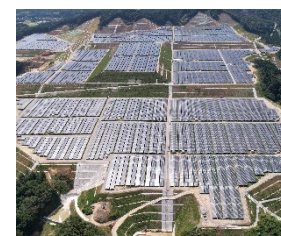
▲太陽光発電設備工事
