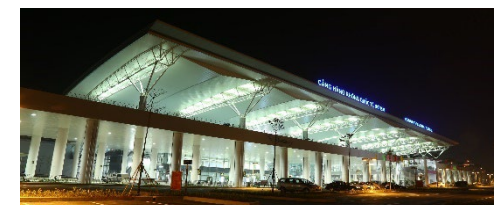
▲ノイバイ国際空港第2ターミナルビル (電気設計・施工管理・電気設備工事)
