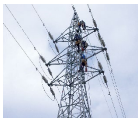
▲架空送電線関連工事
