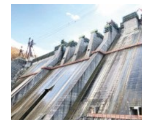
▲ハツ場ダム 電気設備・通信設備工事
