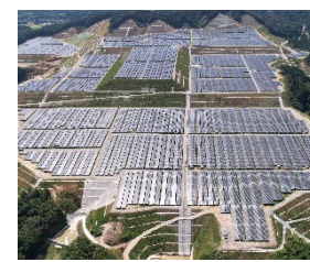
▲太陽光発電設備工事
