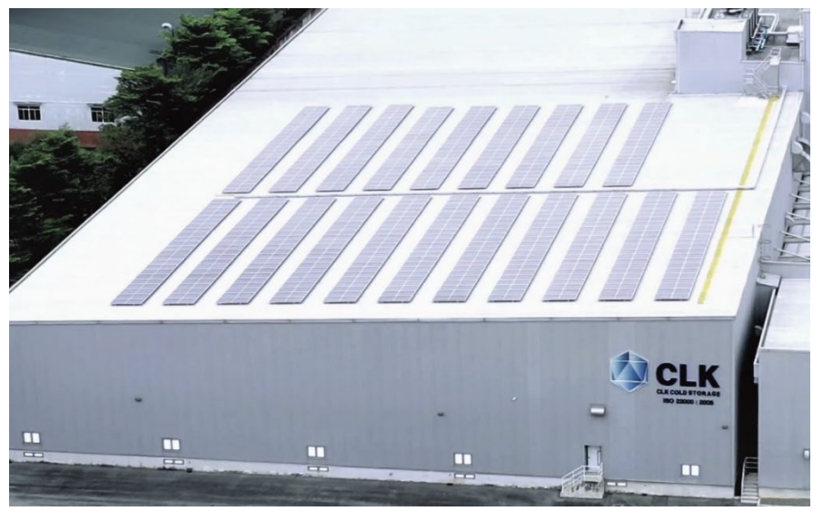
CLK COLD STORAGE ベトナム工場
