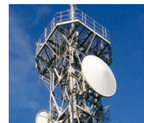
▲防災行政無線工事
